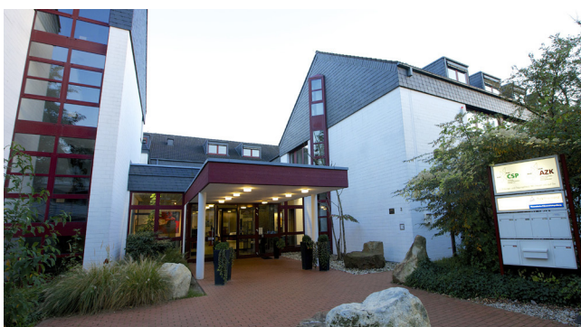
Eingangsbereich des AZK
